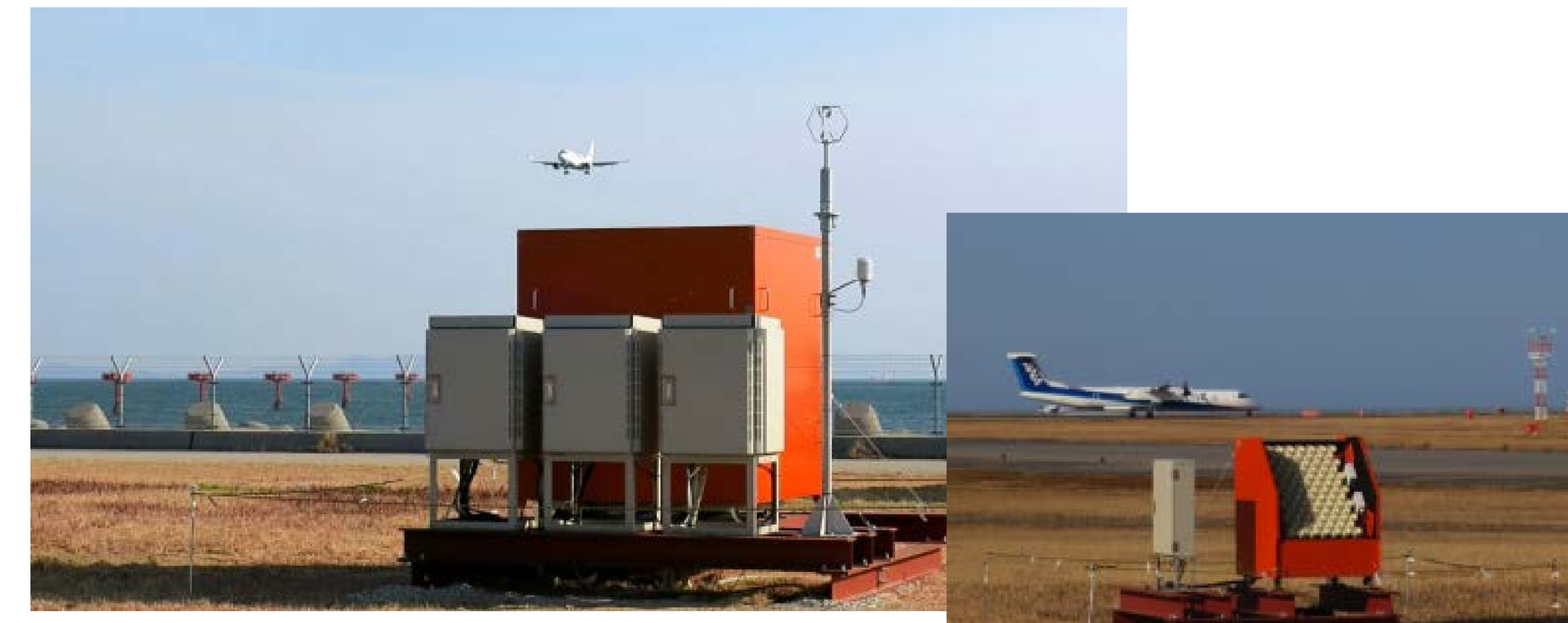
【 SOLWIN風観測センサー設置写真】
