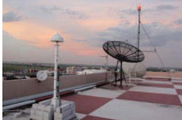
図3 ●タイに設置されたGPS地上観測局（左手前）
