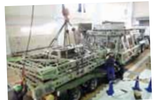
分解した構造体を点検と改修のために搬出する
