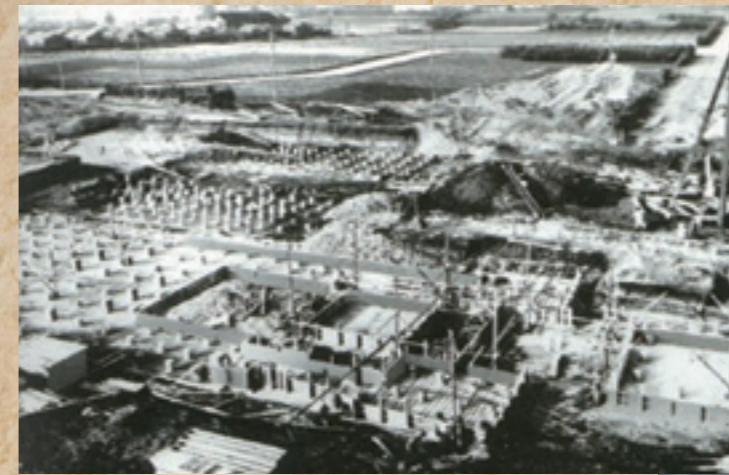
昭和33年(1958年)に撮影された基礎工事中の遷音速風洞。循環式風洞のおおよその形が見て取れる
