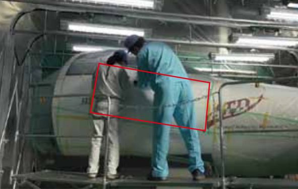
実物大航空機模型への塗装リプレットの施工状況 (首都大学東京との共同研究；赤い四角の部分が塗装範囲)
