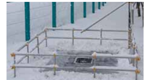
埋設準備中の雪氷モニタリングセンサー（北見工業大学） （上：工事の様子、下：埋設部全景）
