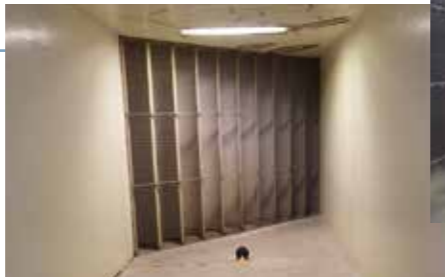
低速風洞第一拡散胴、改修前(左)と改修後(右)。
