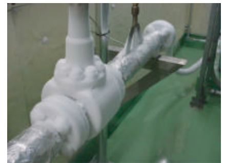
写真3 液体窒素制御弁
