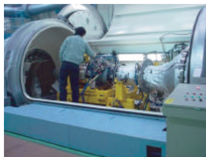
写真2 超音速エンジン試験施設
