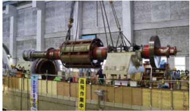
クレーンで吊り下げられる回転子
