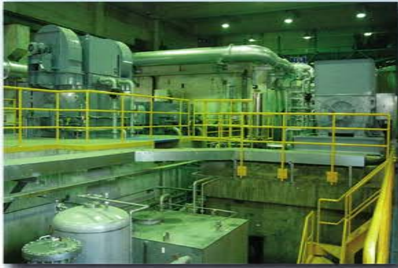
航空推進3号館試験場内
