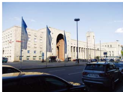
解体が始まった駅舎
