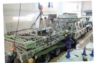
分解した構造体を点検と改修のために搬出する
