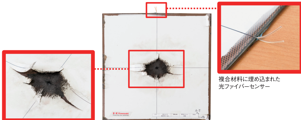
被雷部分の拡大写真
