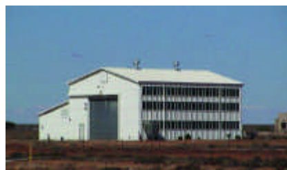
写真5 EFS（Explosive Fitting Shop）
