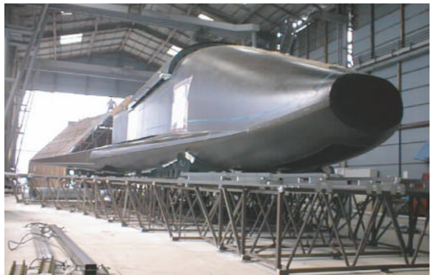
完成した実大機体構造（全長約12m、全幅約9m）
