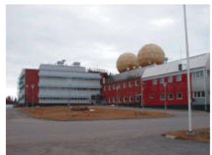
図4 エスレンジ実験場本部ビル
