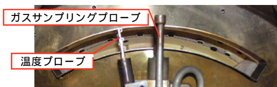
燃焼器下流から見た燃焼器出口
